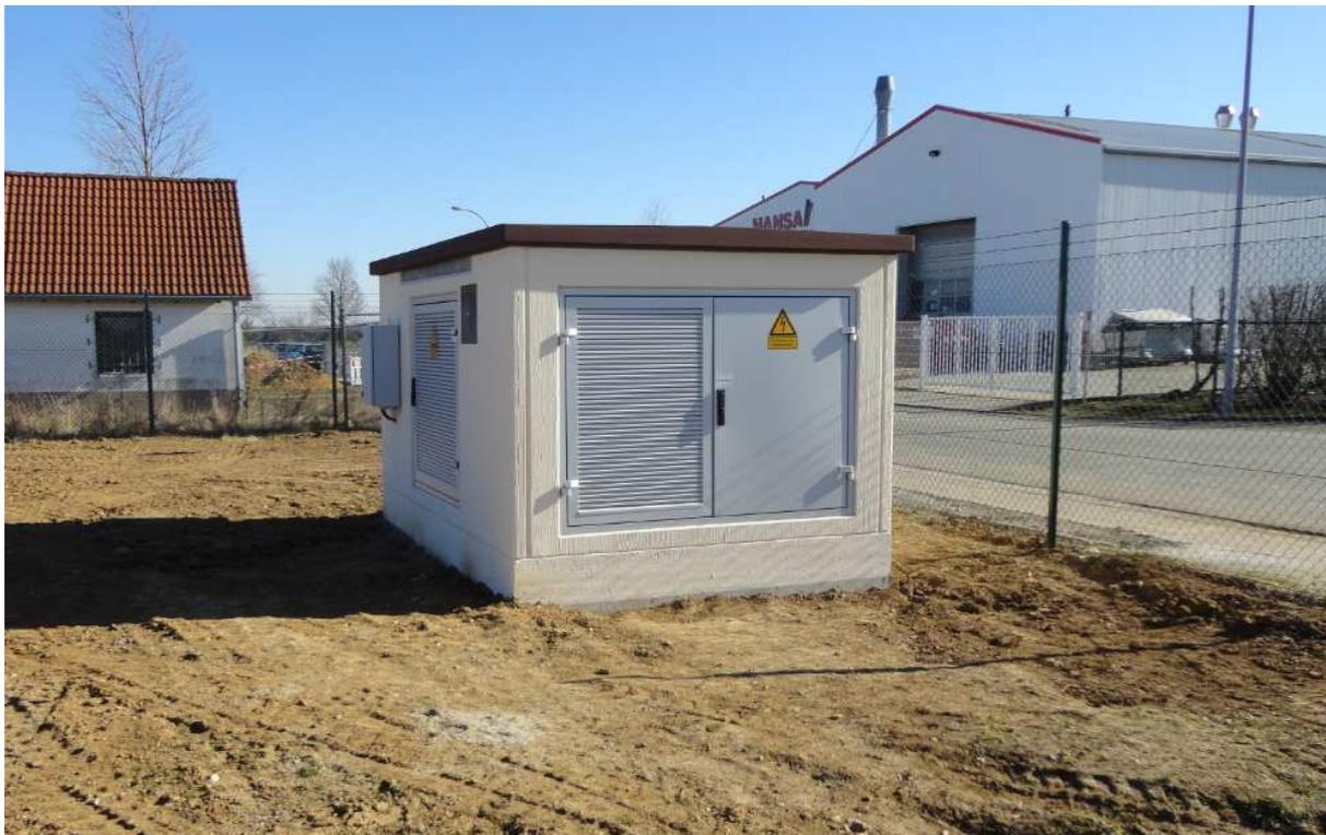
Abbildung 6: Ansichtsbeispiel Transformator-Kompaktstation, Quelle: VISPIRON EPC GmbH, München
