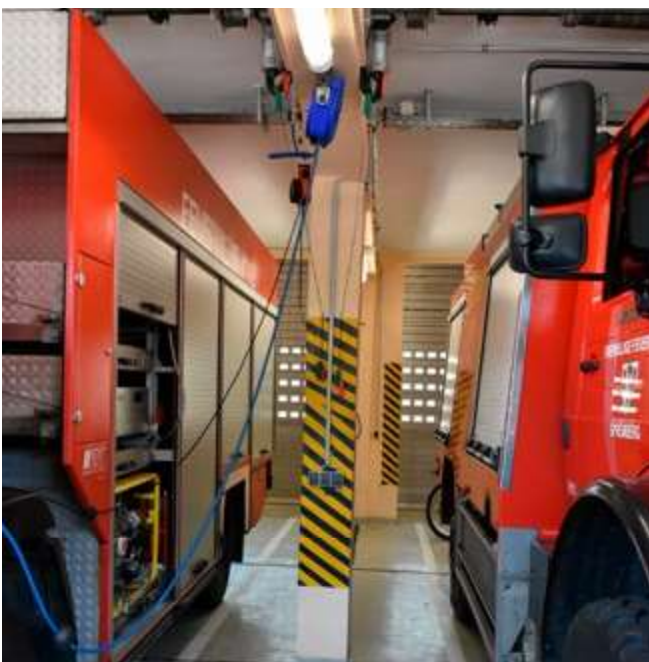
Bild 20 Als Übergangslösung: Markierung der einengenden Gebäudeteile
