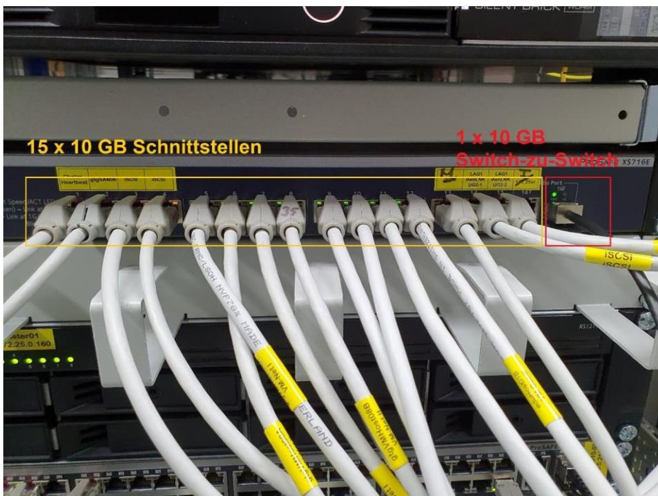
Die aktuelle Switch-Infrastruktur basiert auf einzelnen Switches, die mittels Verbindungskabel miteinander verbunden sind. Das Schaubild zeigt, dass insgesamt 15 Ports mit 10 GB Anschlüssen belegt sind. Diese Anschlüsse müssen nun an andere Geräte, wie etwa Firewall oder das hausinterne LAN, die WLAN-Infrastruktur, Datensicherungsnetz usw. weitergeleitet werden. Dies geschieht über nur einen 10 GB Anschluss, der zum nächsten Switch führt. Der mögliche Durchsatz, den die Server
