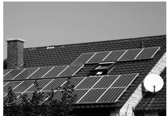
Abb. 9 Unzulässige Anordnung von Solarmodulen, Quelle: Solaranlagen gut gestalten (2013)
