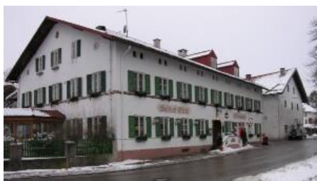
Gasthaus mit Nebengebäude Hauptstraße 13, 13a
