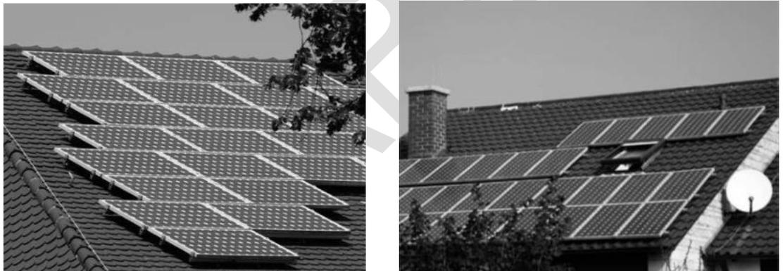
Abb. 9: Unzulässige Anordnung von Solarmodulen, Quelle: Solaranlagen gut gestalten (2013).
